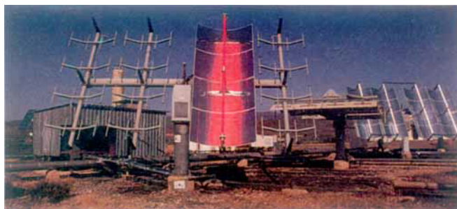
Abb. 11. Im Bild sind rechts (Osten) das MAN-Helioman-Modul und links (Westen) die Versorgungsplattform, die durch eine Wellblechhütte vor Witterungseinflüssen geschützt ist, zu sehen. Im Absorberrohr ist deutlich die rote Farbe des Sensibilisators Rose Bengal zu erkennen. Rechts im Hintergrund ist ein MAN-Helioman-Modul des Detoxifizierungsloops zu sehen. Das Absorberrohr leuchtet weiß wegen der Streuung des Titandioxids.
